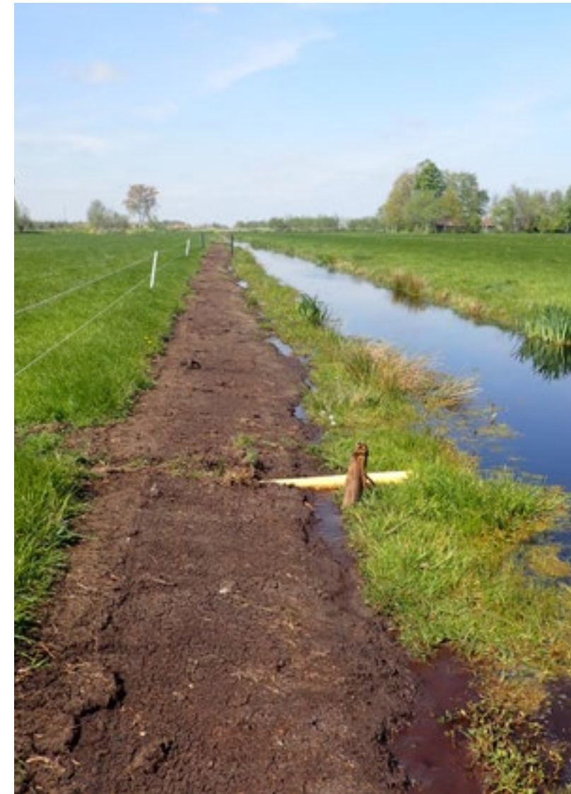
■ Ontgraven en weggedrukken van de teen van de sloot (foto links)
